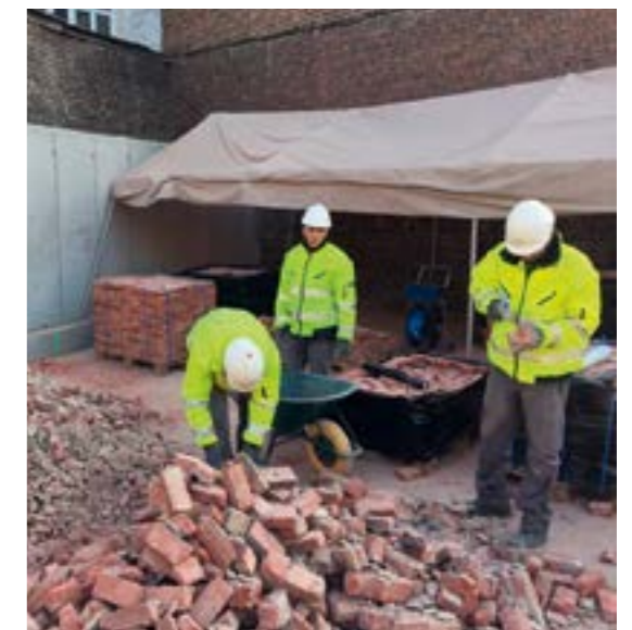
"Vandergoten" - Laeken. TRAVIE, entreprise de travail adapté.
